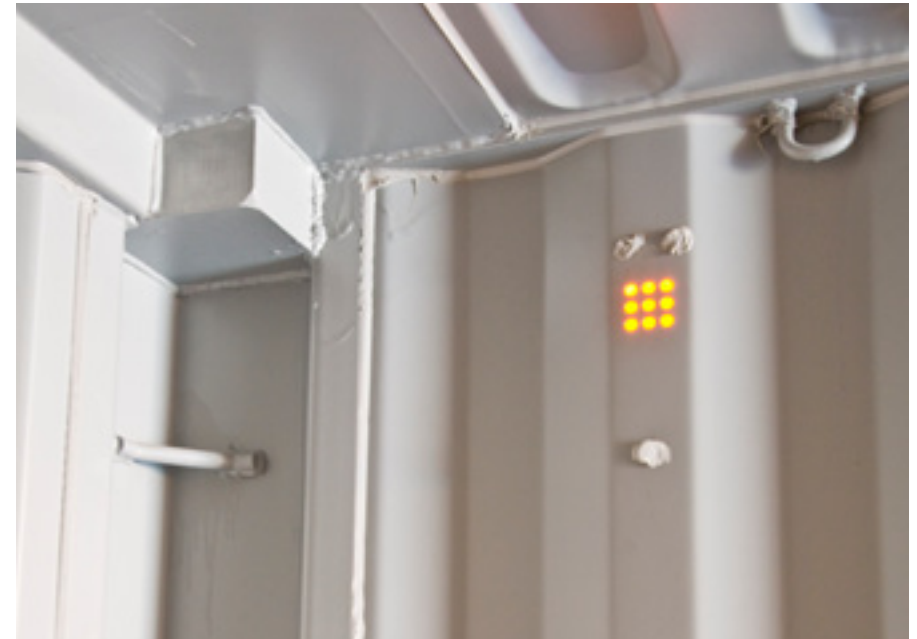
Laschpunkte in einem Standard-Container an der Dachkante, am Eckpfosten und kleine Löcher zum Luftdruckausgleich
