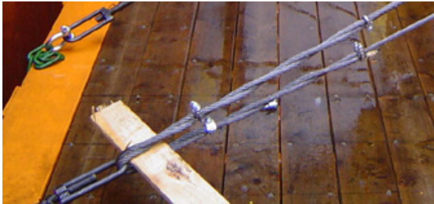
Korrekte Laschenanordnung. Die Enden des Stahldrahts sind verdreht, um die Reibung zu erhöhen
